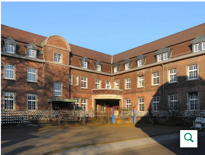
Die Licht- und Lohnhalle des ehemaligen Bergwerks Lohberg. Foto: Heiko Kempken
